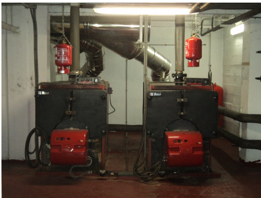
Ilustración 4: Calderas de Gasoil
