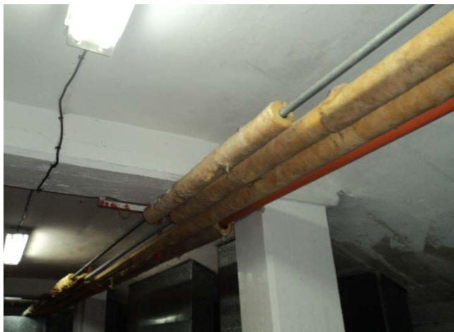
Ilustración 6: Tuberías agua caliente sala depuración
