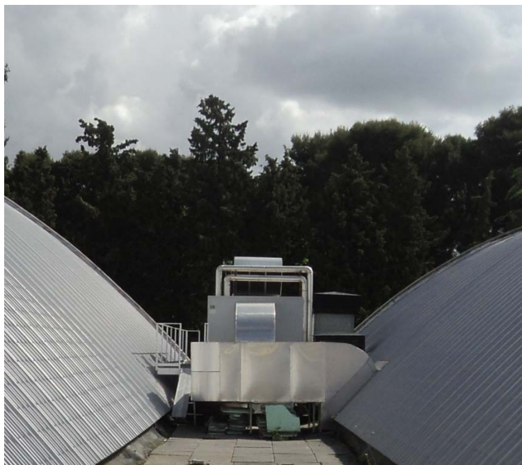
Ilustración 9: Unidad de Tratamiento de Aire del recinto Piscina
