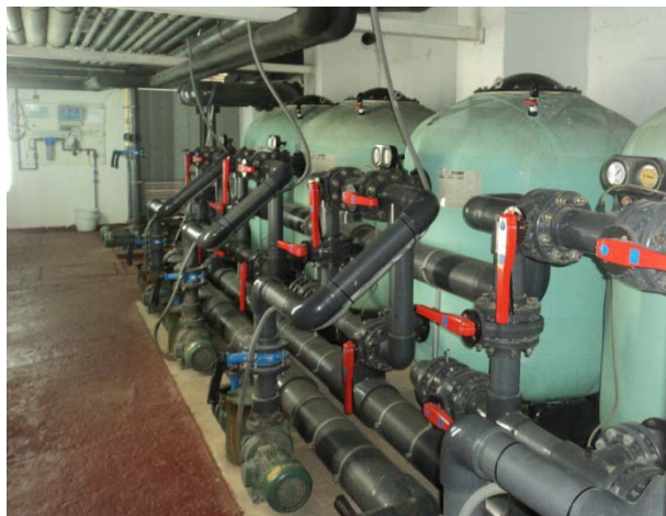
Ilustración 7: Equipos de filtrado
