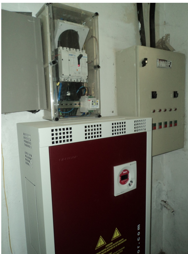
Ilustración 12: Suministro eléctrico con batería de condensadores
